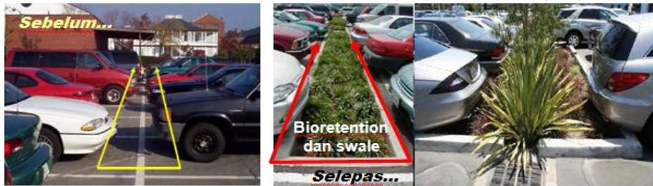
Bioretention di sepanjang sisi jalan
